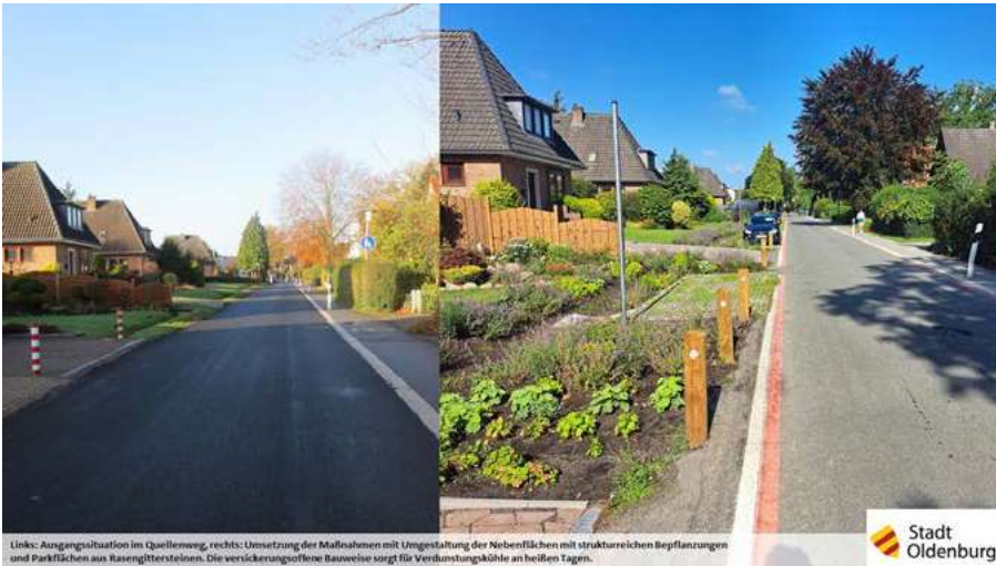
Links: Ausgangssituation im Quellenweg, rechts: Umsetzung der Maßnahmen mit Umgestaltung der Nebenflächen mit strukturreichen Bepflanzungen und Parkflächen aus Rasengittersteinen. Die verdückerungsoffene Bauweise sorgt für Verdunstungskühle an heißen Tagen.
