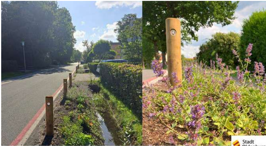
Umsetzung der neuen Gräben und biodiversitätsfördernde Bepflanzungen am Straßenrand.
