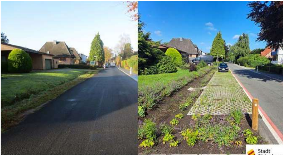
Links: Ausgangssituation im Quellenweg, rechts: Umsetzung der Maßnahmen Parkflächen, Begrünung und umgestalteten Gräben
